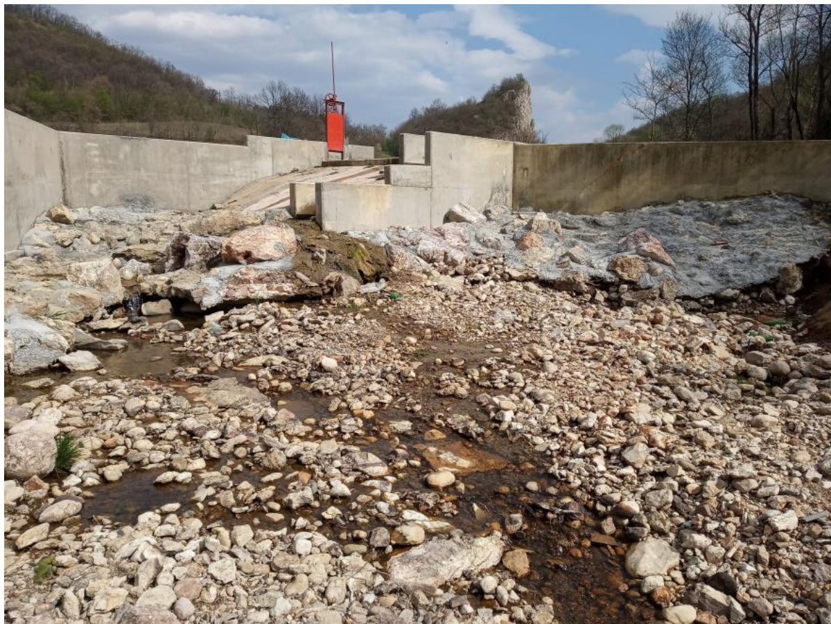
Vodozahvat MHE „Čitluk“ i prekinut tok reke Izgare, foto SED, april 2019.
